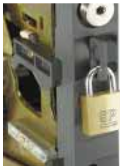
Enclavamiento en posición "desenchufado" por candado
