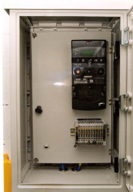
Módulo de Medida de dimensiones mínimas 750x500x300 mm de acuerdo a RPM según normas de Iberdrola.
